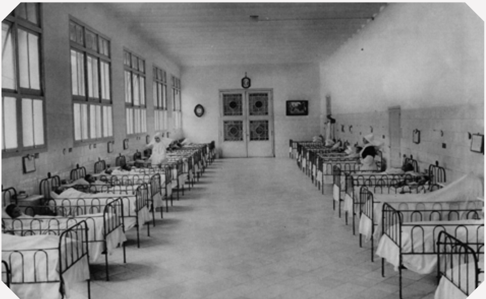
Sala de enfermería Hospital General de Valencia
